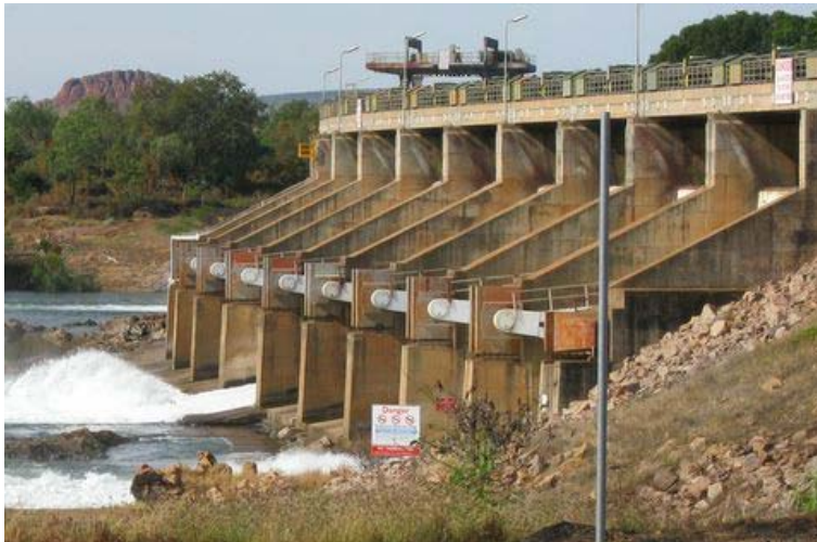
Kununurra Diversion Dam
